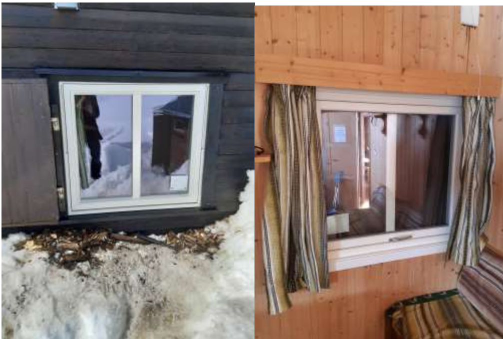
Skifte av vindu på beitelagsrommet på Grønenuten. Råteskader i og under det gamle vinduet. Dette ble byttet ut og nytt vindu satt inn.
