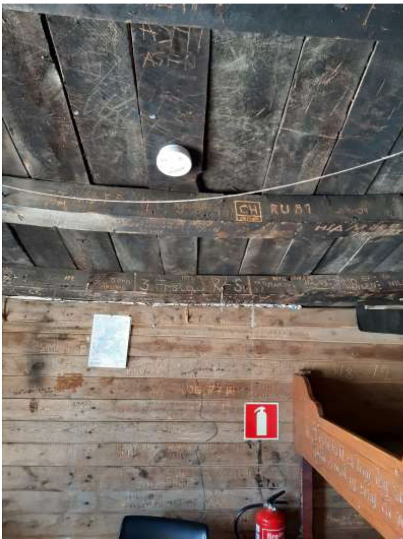
Sæltjønnslegeret- røykvarsler og brannslukningsapparat.
