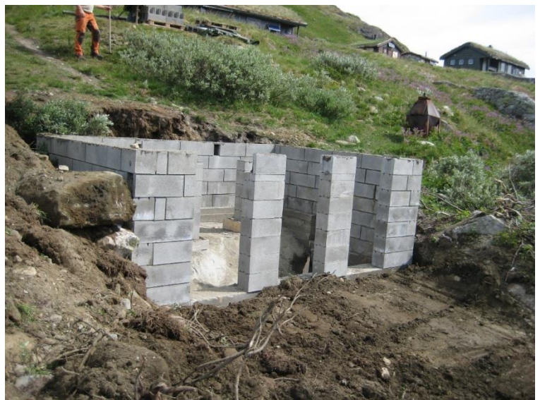
Figur 4. Grunnmuren på ny do på Hansbu blei sett opp sommaren 2018. Foto: Hardangervidda Fjelloppslyn.
