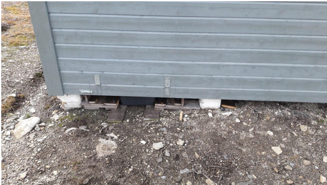
Figur 2. Løysing for tøming av dokagge på Ullensvang fjellstyre si hytta på Raudåna.
