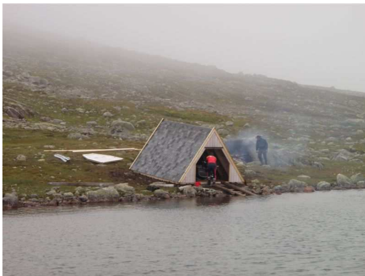
Naustet ved Store Meinsvatn vart teke i bruk i 2010 Foto: Rauland Fjellstyre
